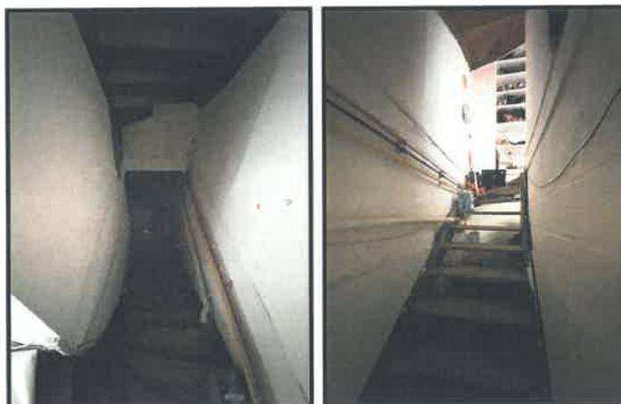
Les murs sont recouverts d'enduit blanchi en première partie et au niveau de la partie sous-sol, de parpaings de fondation blanchis.
