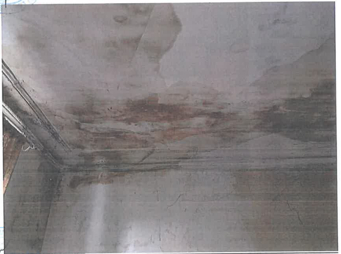
Vue des infiltrations au plafond de la chambre 1
